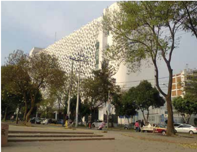
Figure 14. Façade of Torre de Especialidades [51].
